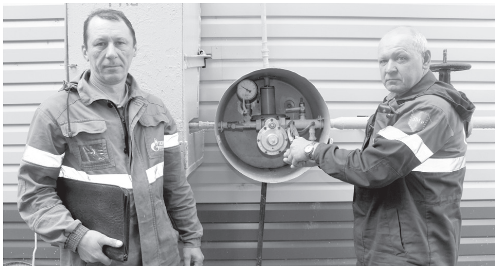
Работники ПАО «Газпром газораспределение Нижний Новгород» Александр Провидохин и Владимир Пшеничнов проверяют состояние шкафного газорегуляторного пункта.
